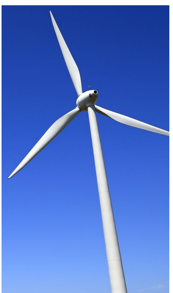
Rüzgar türbini yapıları
